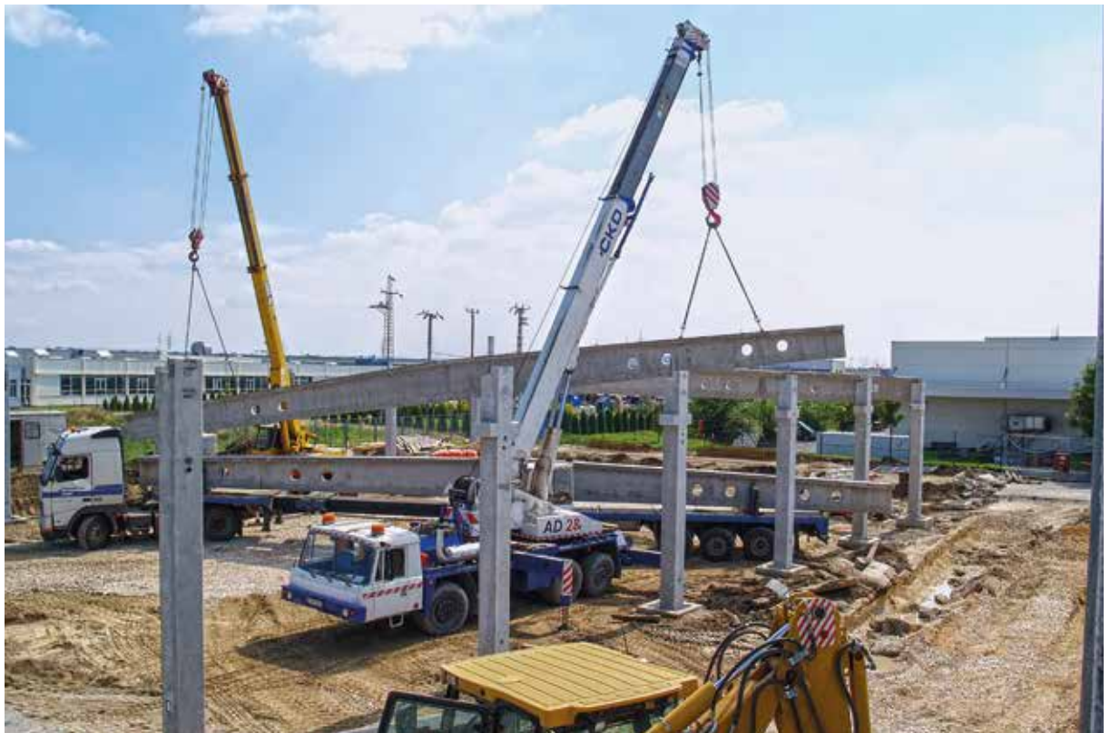
A Borsodi legnagyobb beruházása a hőkezelő megépítése volt, csak az épület 400 millió forintba került
